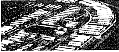
"Rækkehus-Værksteder" til Udlejning. Hillington Trading Estate, Skotland.
